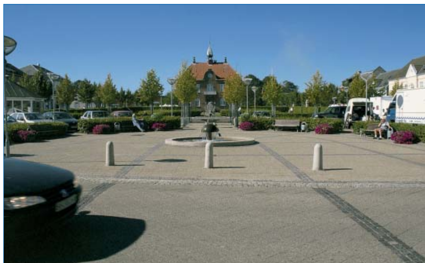
Farten dæmpes uvilkårligt når man kører fra en asfaltvej ind på betonbelægningssten. Her er vejen en smuk og integreret del af et torv. Etableret i 1993 (Kjellerup).
