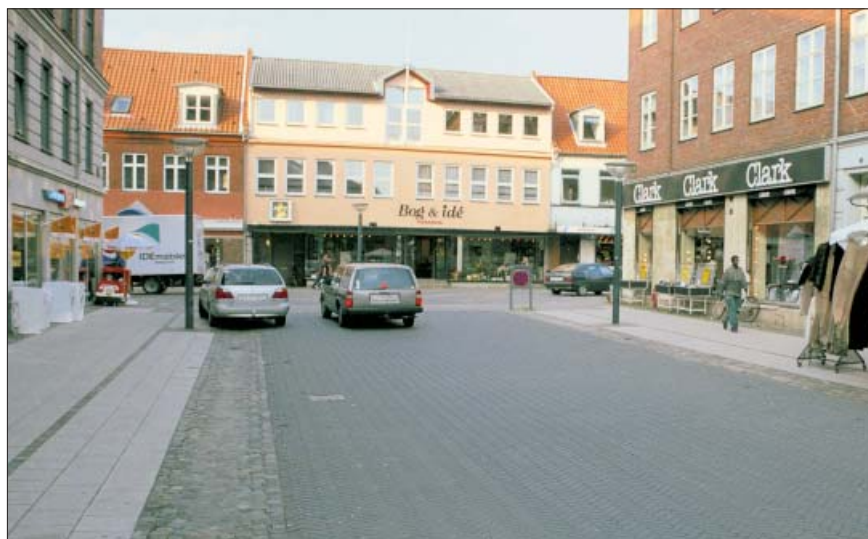
Med vejbane og fortovej i samme niveau har man med et bånd af chaussésten som markering skabt en mellemting mellem at adskille og blande biler, cykler og gående i denne bymidte. Etableret i 1992 - 1994 (Ringsted).
