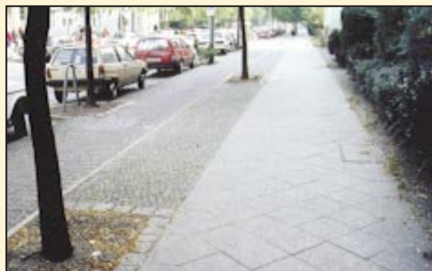
Fortov i London med rektangulære fliser med skifter i forskellig bredde og bredde i faldende længder.
