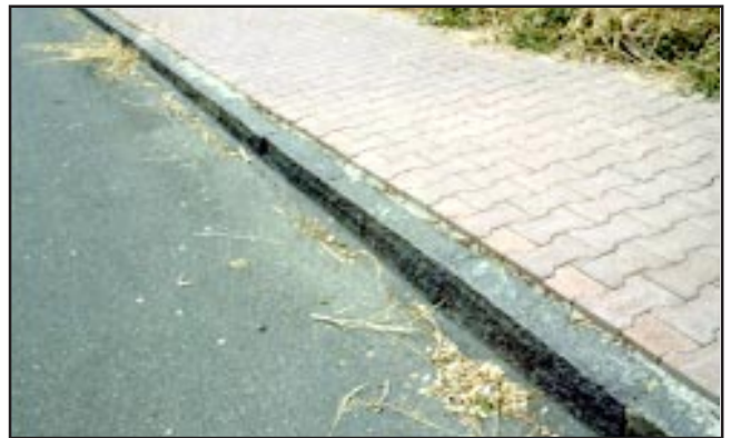
Belægningsstenens overhøjde og aftrækketsplanefald mod kantstenen skaber et uharmonisk sammenstød mellem kantstenen og fladen.
