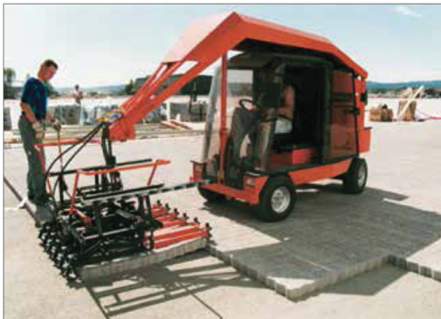
Maskinnedlægning af betonsten – hurtigt og effektivt.
