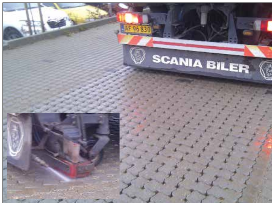
Oprrensning af fuger, med specialkøretøj der spuler og suger.
