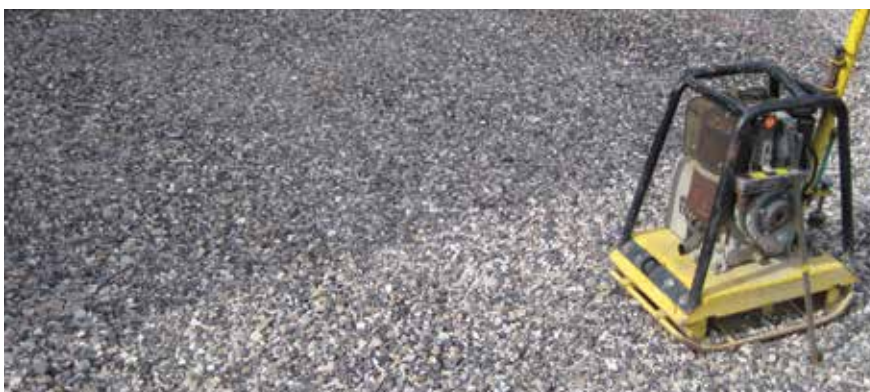
Vibrering af bærelag uden finstof og med ca. 30 % porevolumen.
