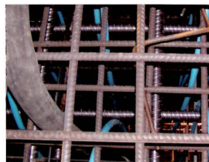
Figur 21. SCC er særlig egnet til komplicerede støbninger, hvor det er svært at få vibreret traditionel beton ordentligt.
