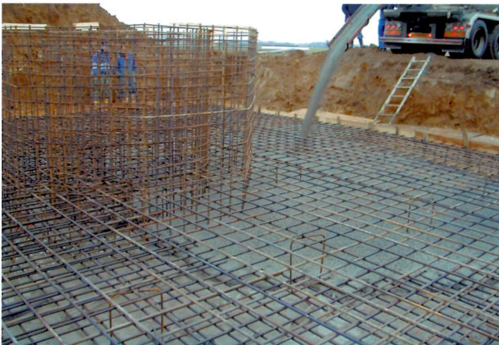
Figur 1. Udstøbning af fundament med selvkomprimerende beton, også kaldet SCC. Brug af vibrationsudstyr er ikke nødvendigt for at placere betonen korrekt, hvorfor både støj og tid brugt på selve udstøbningsopgaven kan reduceres i forhold til, hvis der var brugt konventionel sætmålsbeton.
