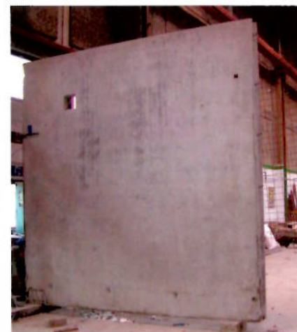
Figur 22. Den færdige kvalitet af overfladen afhænger bl.a. af hvor slidte forme, der er brugt, og om der er brugt for meget formolie.
