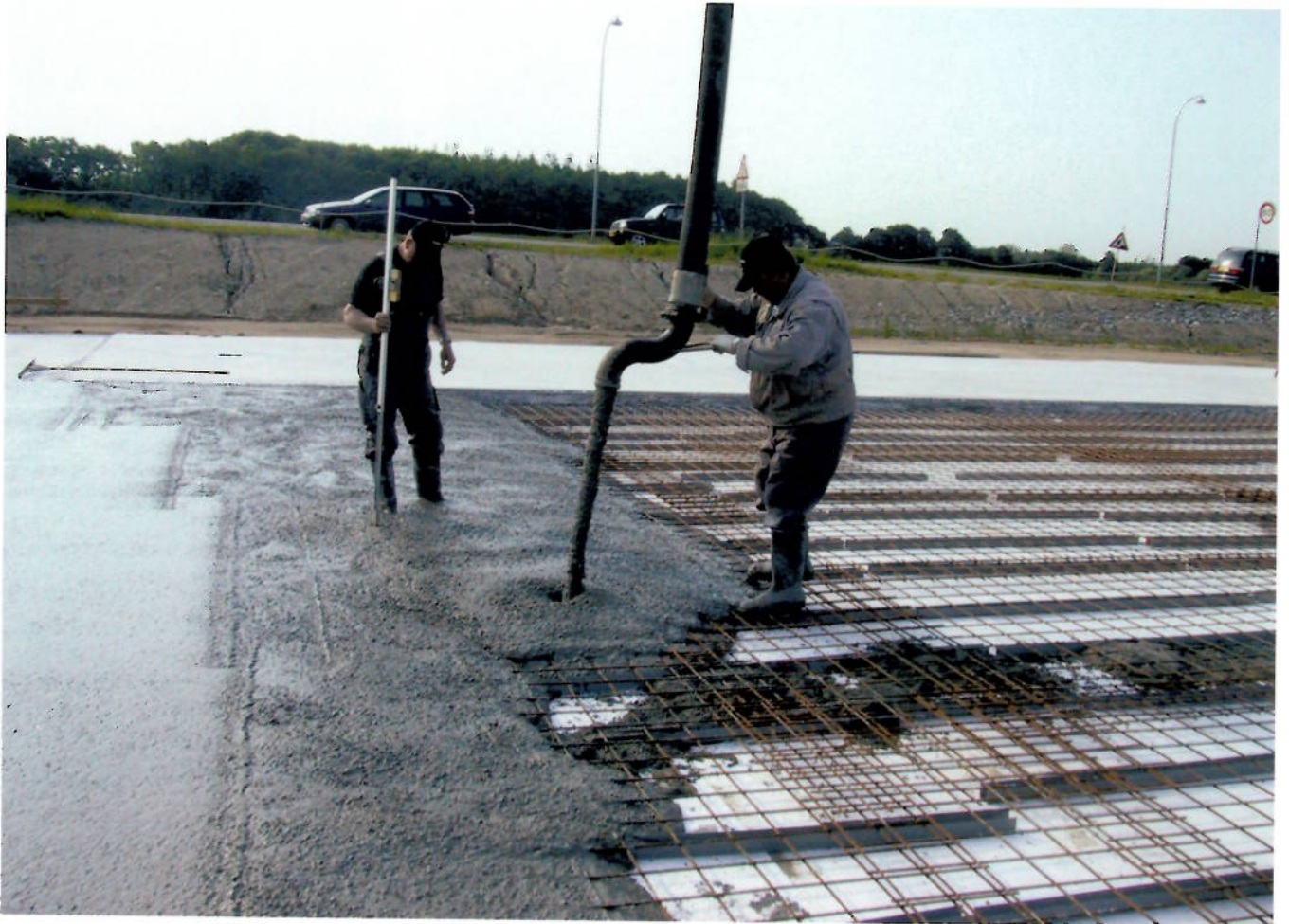
Figur 16. Udlægning af SCC med opbygget støbefront.
