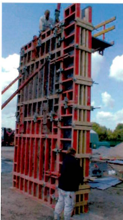
Figur 24. SCC pumpes i høj form med pumpebetonen neddykket i betonen.
