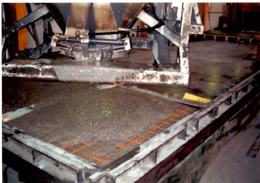
Figur 19. Vandret udstøbning af betonelement.
