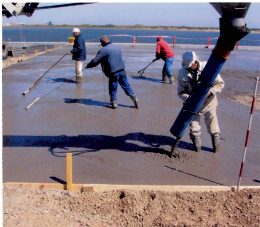
Figur 15. SCC øger produktiviteten ved store gulvstøbninger.
